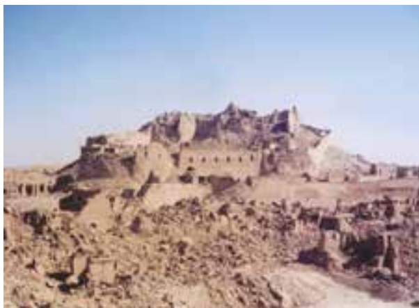
(ب) ارگ بم بعد از زلزله
